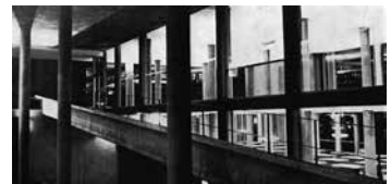
Fig. 9. Vista del espacio cubierto exterior de la rampa del Carpenter Center, 2014. Fotografía del autor.
